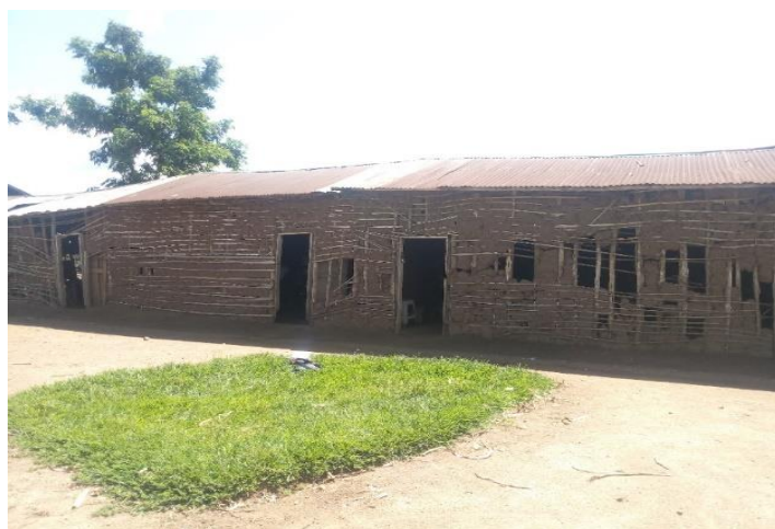
EP NYAKIMA située dans l'AS BUHUMBANI, une école avec 217 écoliers dont 107 filles et 110 garçons qui utilisent 2 portes de latrines dont une pour les filles et l'autre pour les garçons.
