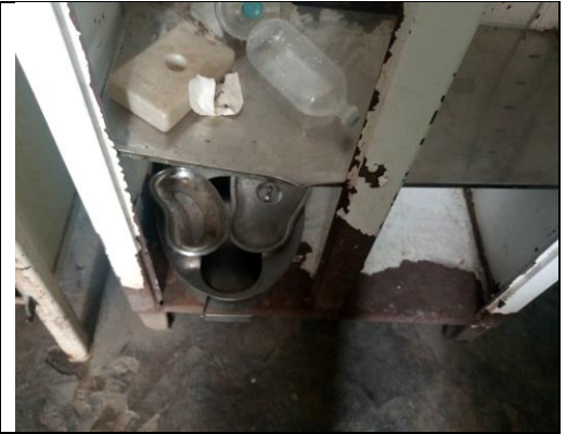
Figure 11 : Boite à outils en état délabrement
