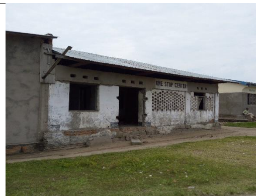
Figure 2: Centre Intégré des Services Multisectoriels (CISM) en cours de réhabilitation à Lusambo
