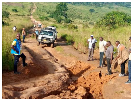
Figure 19 : Tronçon routier Mutombo Dibwe et Bakwambumba
